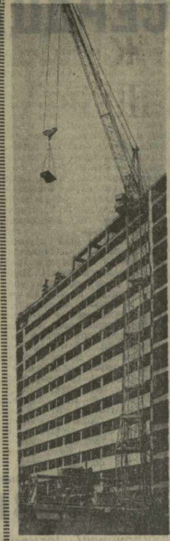
Быстрыми темпами ведется строительство одного из крупнейших в Грузии лечебных центров — республиканской клинической больницы в Тбилиси. На снимке: один из участков строительства. Фото М. Квирикашвили.
