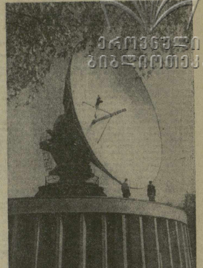
Завтрашний день связи — это новая техника, новые скорости передачи информации, лучшее качество передач. На снимке: пункт «Орбита» для связи с Москвой через космос.
