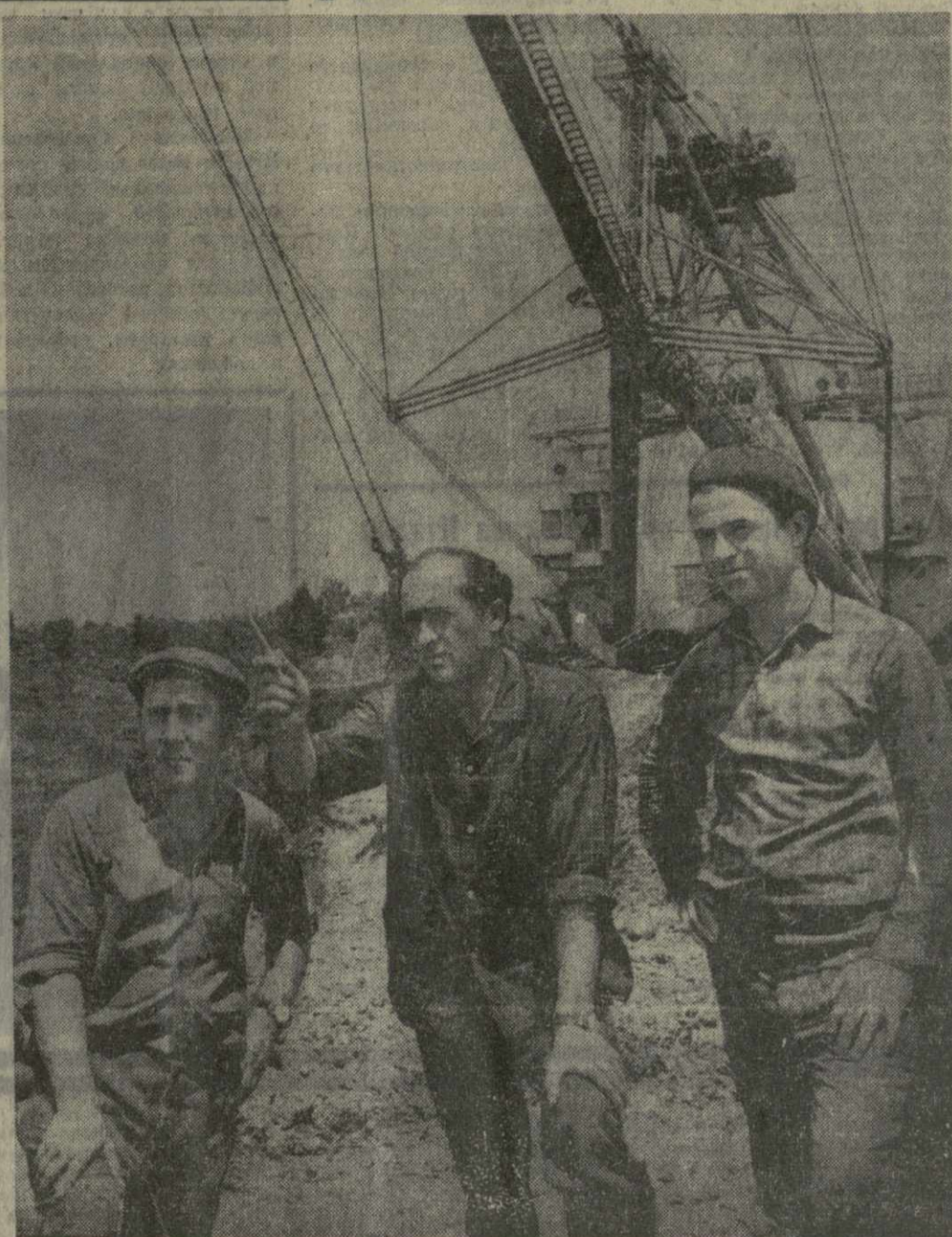
Широким фронтом идут строительные работы по сооружению ИнгуриГЭС. На помощь строителям пришла мощная техника. Коллектив папающего экскаватора 9Ш 1075, которым руководит Герой Социалистического Труда Владимир Саламатов, за сутки прокладывает 20 метров готового оголового канала переправой ГЭС-1.
