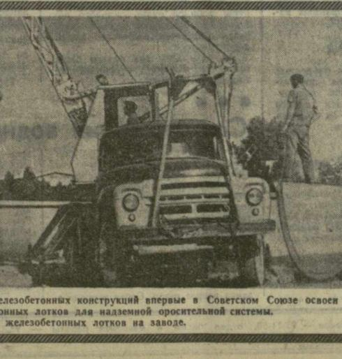
На Лилейском заводе железобетонных конструкций впервые в Советском Союзе освоены выпуск предварительно напряженных тонкостенных железобетонных лотков для наземной оросительной системы. На снимке: погрузка железобетонных лотков на заводе.
