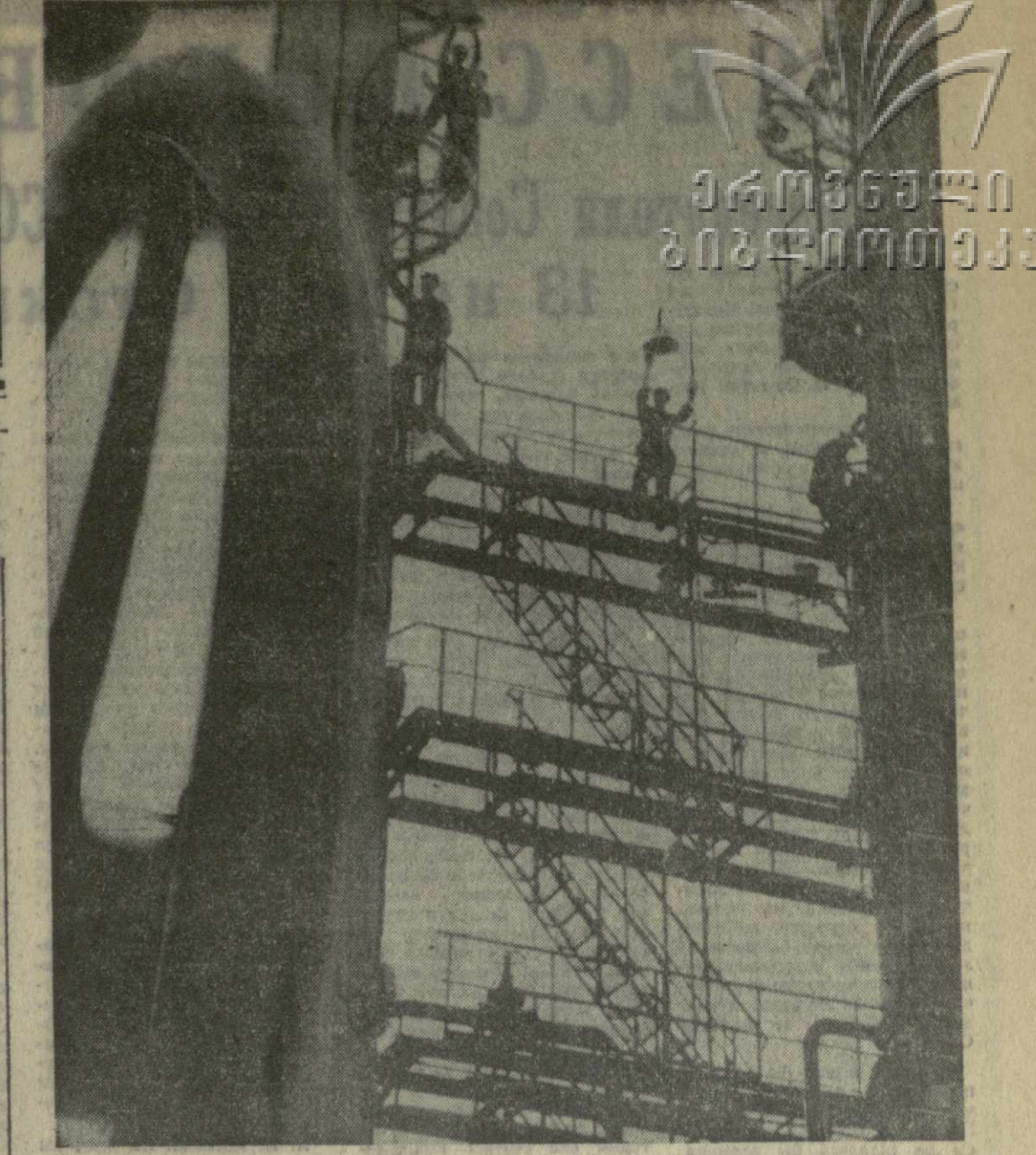
Тысячи тонн нефтяного сырья сверх плана переработано за первое полугодие третьего года пятилетия на Батумском нефтеперерабатывающем заводе. Сейчас здесь ускоренными темпами идет сооружение новой мощной установки по выпуску высококачественного автомобильного бензина.
