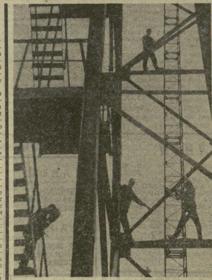
В городе строится флотационная фабрика, началось сооружение 14-этажного высотного здания. На снимке: один из участков строительства флотационной фабрики. Фото А. Мачавариани. (Фотолотерия ГрузТАГ).
