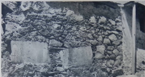
38. Кладка каменной стены.
