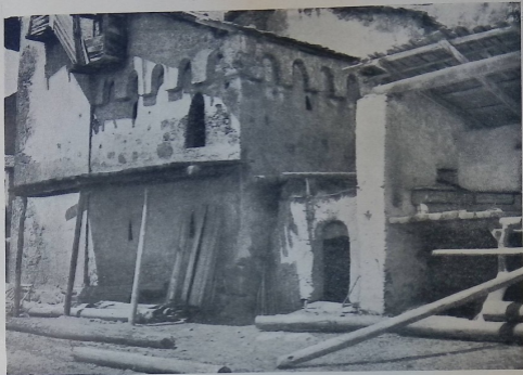
53. Деталь южного фасада дома Хергани в деревне Лектал.
