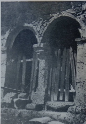
70. Южный вход в Пкотерскую церковь в Дзержском обществе.
