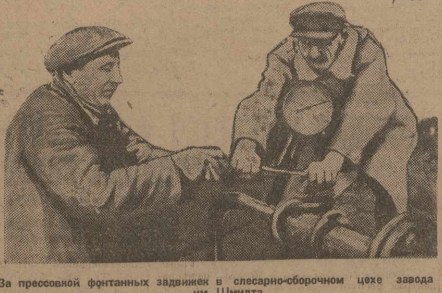
За пресовой фонтанной задвижке в слесарно-оборочном цехе завода им. Шмидта
