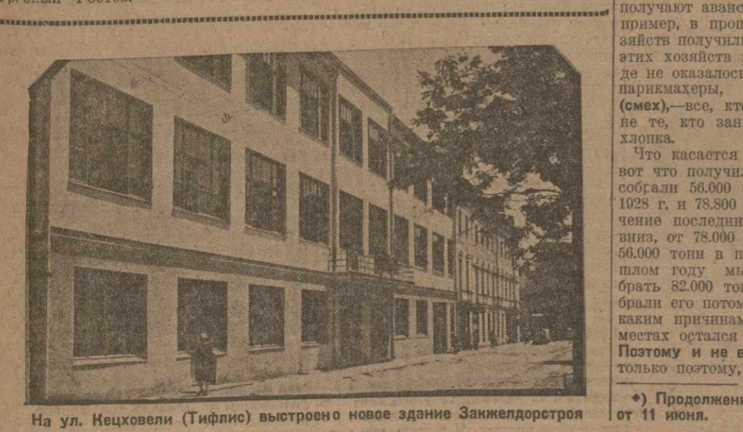
На ул. Нохчевели (Тифлисе) выстроено новое здание Женкелдорострой
