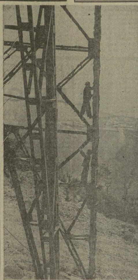
На строительстве ИнгуриГЭС монтируется канатная дорога, которая будет подавать бетон на строительную площадку возводимой плотины. На снимке: один из участков монтажа канатной дороги. Фото М. Квирикашвили.
