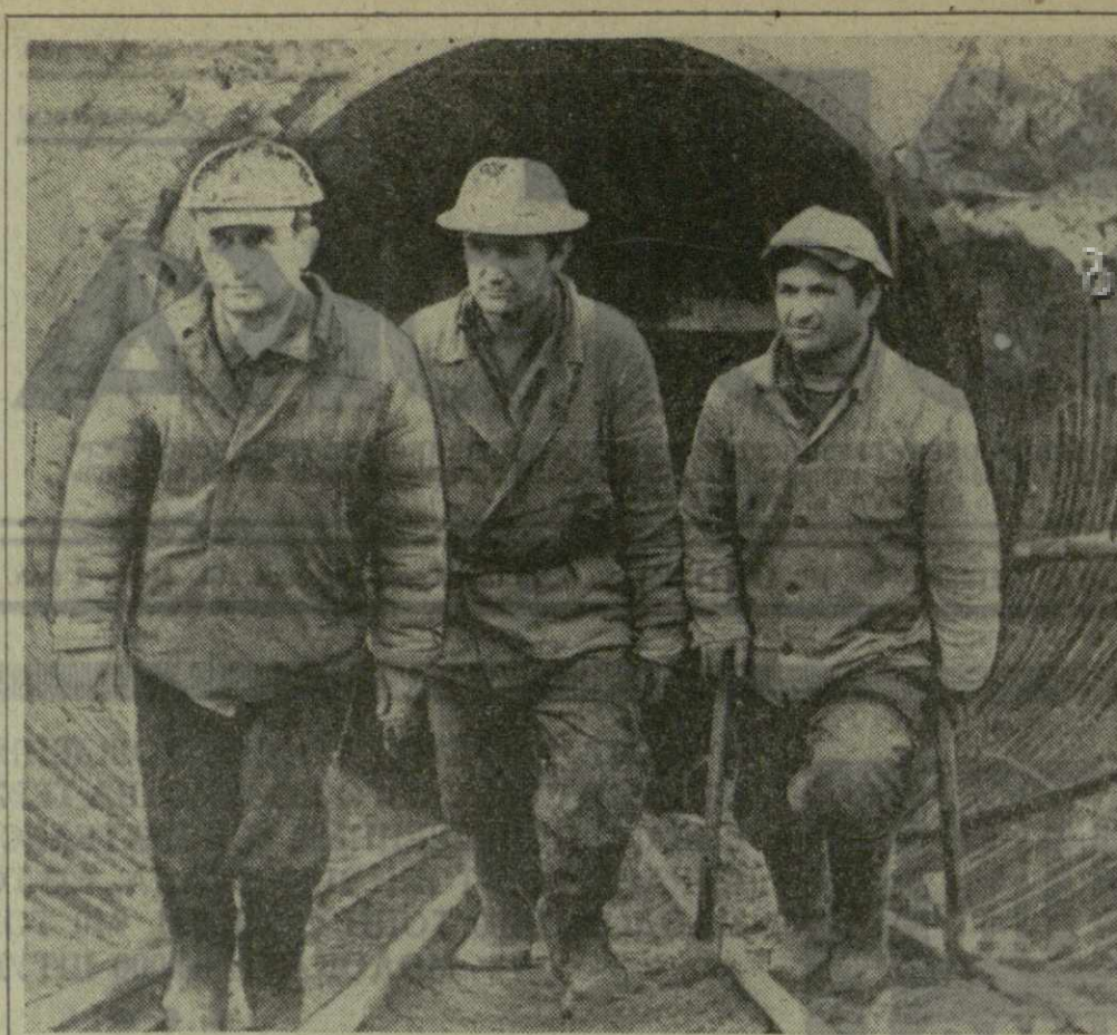
Продолжается строительство второго наклонного хода, который соединит Октябрьскую улицу со станцией метро «Площадь Вокзальная». Проходка уже завершена, сейчас метростроители проводят гидроизоляционные работы и приступили к строительству вестибюля. Строительство будет закончено к 7 ноября 1969 года.
