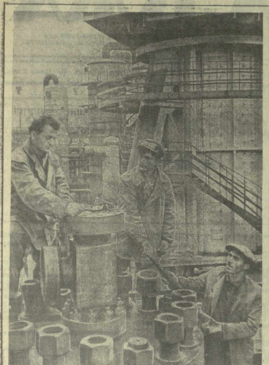
Вчера плечом к плечу со строителями второй очереди электростанции Ингура в долине реки Ингур в Грузии трудились учащиеся Руставского профессионального училища № 17. Будущие строители внесли свой посильный вклад в крупнейшую в республике стройку, обогащая практический опыт. На снимке (слева направо): бригадир монтажников В. Джамаспашвили, монтажник С. Якуба и мастер профессионального училища В. Тарвашидзе. Фото Г. Вахтагандзе.
