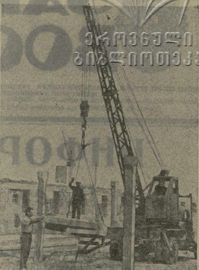
На снимке: на строительстве Меджврисхевской птицефабрики.
