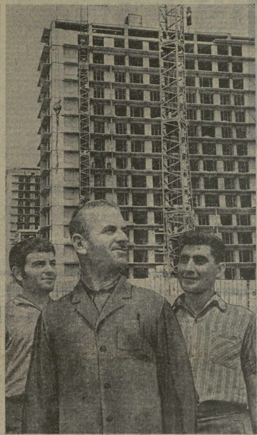
На снимке: (слева направо) передовые строители управления «Южстальконструкция» — бригадир монтажников Г. Корогайлишвили и рабочие Г. Бедондзе и И. Муштафеев.
