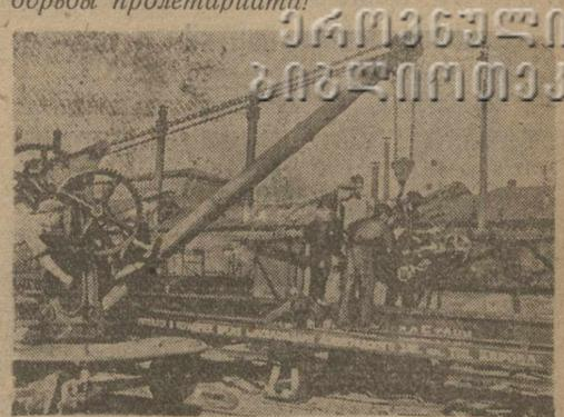
Комсомольская ударная бригада завода им. Нирова в Ленинграде в подарок XVII МЮД в неурочное время строит 5-тонный подъемный мостовой кран для Магнитострой. На снимке: установка подъемной тележки на кране — подарок XVII МЮД.
