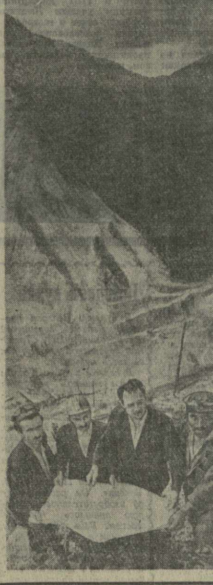
На снимках: слева — группа гидростроителей во главе с главным инженером строительного управления «Плотнстрой» Н. Эмухвари за разработкой очередной задачи; справа — базовые цементные элеваторы.
