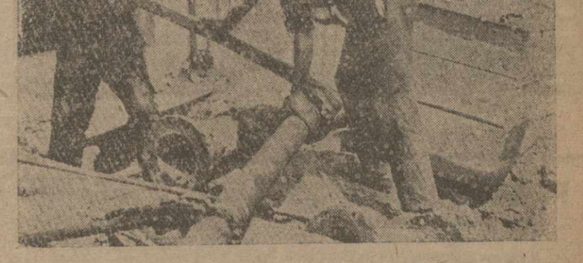
СУРАХАНЫ. 6-й промысел. Готовя гол к фонтану, собирают трубопровод.
