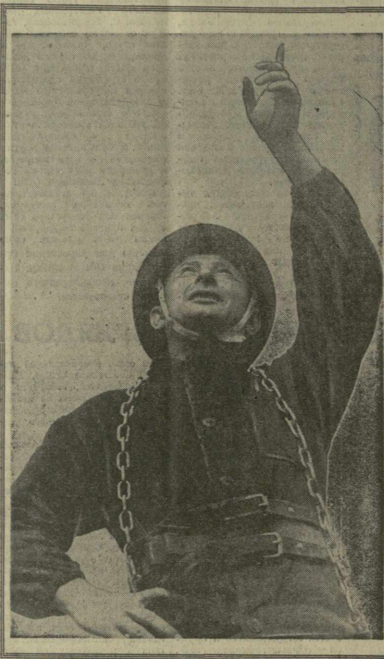
МОНТАЖНИК ГЕОРГИЙ ДЖИГАУРИ
