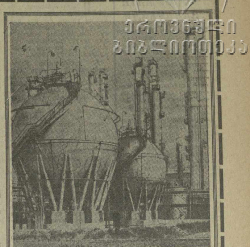
ОДИН ИЗ КРУПНЕЙШИХ В ЕВРОПЕ. Строящийся в народной Польше Плонский нефтехимический комбинат будет одним из крупнейших в Европе. На снимке: резервуары и башни завода будапешта. Фото ЦАФ—ТАСС.
