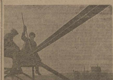
. брики. Уравниловка и плохне бытовые ус- НУЗНЕЦИСТРОЙ, Заклепка конструкции мартеновского цеха на высоте 80 футов. Вдали — вид на стройку ГРЭС, домны и кауперов.
