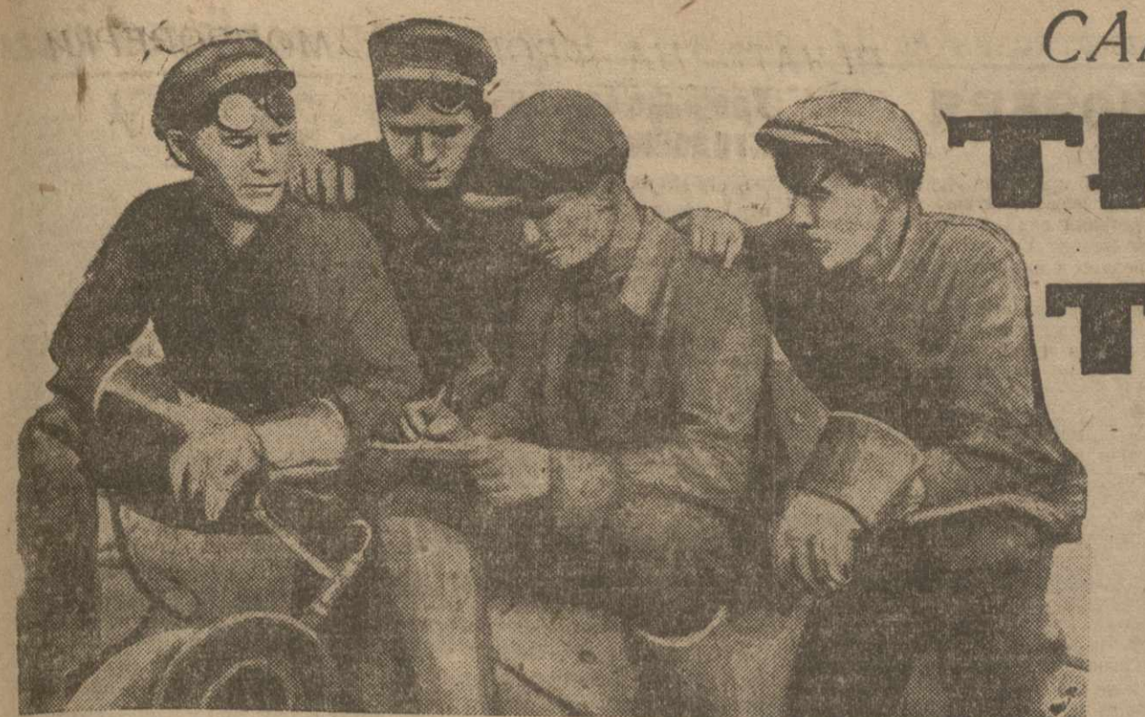
Нефтепромысловые заводы им. Дзержинского (Баку). В дни самопроверки, рабочие автономно-самоуправляемого цеха...
