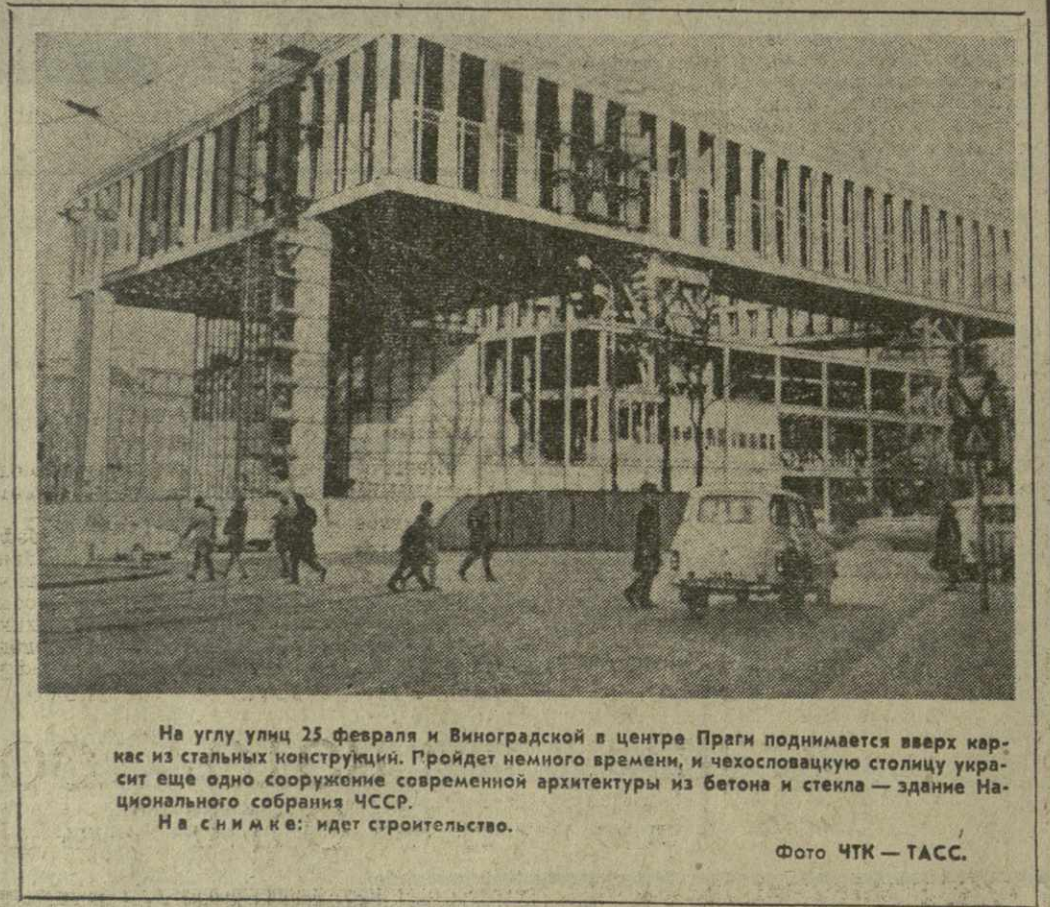
На углу улиц 25 февраля и Виноградской в центре Праги поднимается вверх каркас из стальных конструкций. Пройдет немного времени, и чехословацкую столицу украсит еще одно сооружение современной архитектуры из бетона и стекла — здание Национального собрания ЧССР. На снимке: идет строительство. Фото ЧТК — ТАСС.
