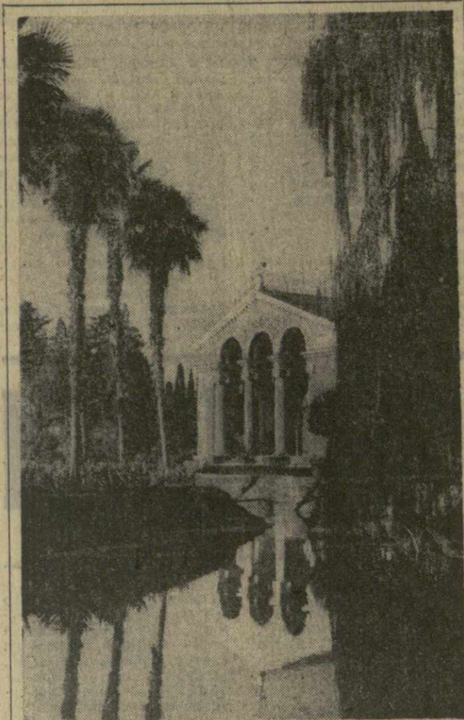
С каждым годом появляются новые здания на побе- режье Черного моря. На снимке: Дом культуры для рабочих и служа- щих Гагрского цитрусосового совхоза. Фото М. Кавришавили.
