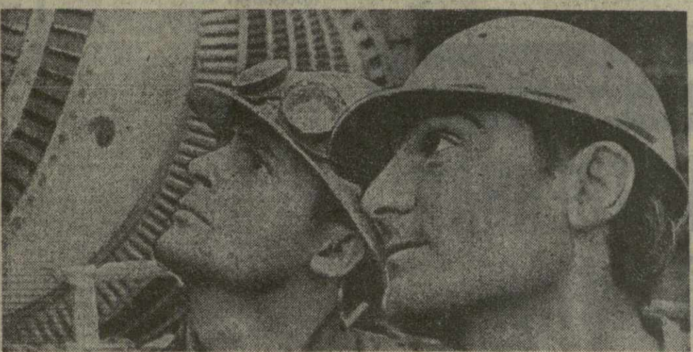
Хорошо работают в эти дни труженики Тбилисской ГРЭС. Эксплуатационники провели большую работу по реконструкции отдельных узлов, в результате чего довели агрегаты до проектных мощностей. На снимках: один из участков станции. Справа — передовые рабочие О. Мдианшвили и С. Алекшвили.
