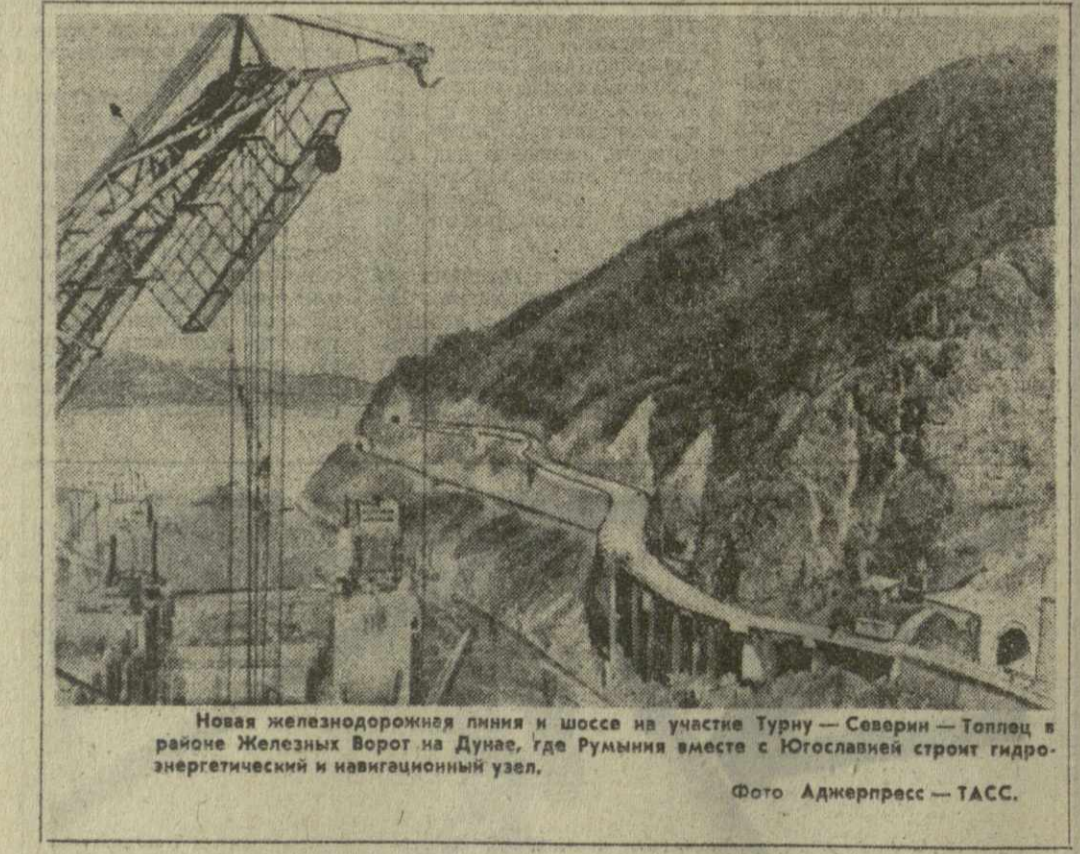
Новая железнодорожная линия и шоссе на участке Турну — Северин — Топлец в районе Железных Ворот на Дунае, где Румыния вместе с Югославией строит гидроэнергетический и навигационный узел.
