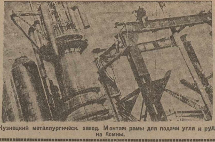
Музочный металлургический завод. Монтаж рамы для подачи угля и руды на Ломы.
