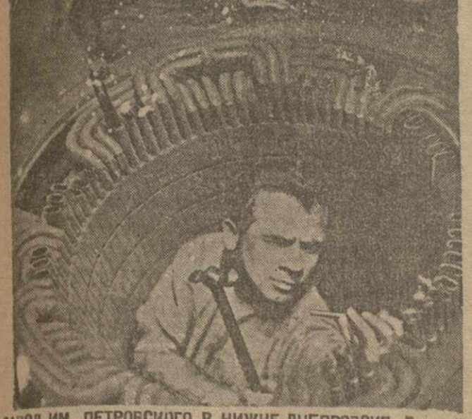
ЗАВОД ИМ. ПЕТРОВСКОГО В НИЖНЕ-ДНЕПРОПЕТРОВСКЕ. Лучший ударник цехового завода, намотчик тов. Гаюпольский, за монтажом статора электромотора
