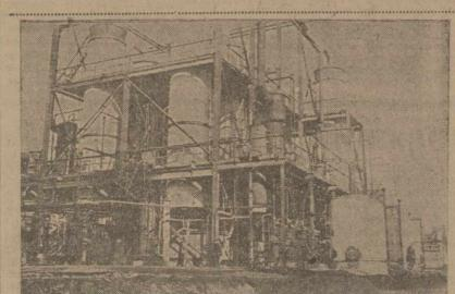
Установка трубчатки «Вильке» для перегонки масел на нефтеперегонном заводе им. Алеши Джапаридзе (Баку).
