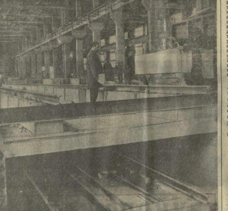
На Тбилиском комбинате производственных предприятий № 2 треста «Стройиндустрия» монтируется новый высокопроизводительный двухъярусный стан для выпуска стеновых блоков. На снимке: монтаж стана. Фото Е. Гусака.
