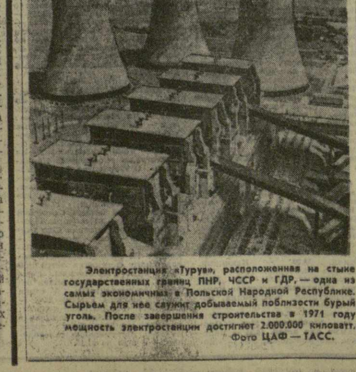
Электростанция «Гуруа», расположенная на стыке государственных границ ПНР, ЧССР и ГДР, — одна из самых экономичных в Польской Народной Республике. Сырьем для нее служат добываемый поблизости бурый уголь. После завершения строительства в 1971 году мощность электростанции достигнет 2.000.000 киловатт. Фото ЦАФ — ТАСС.
