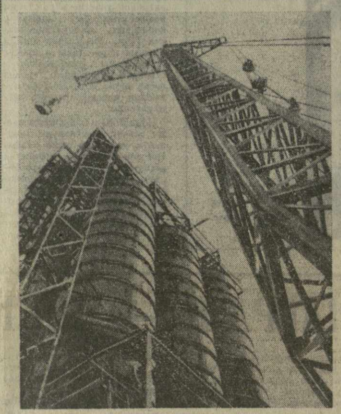
На снимках: слева — передовая бригада монтажников: Станислав Шапко, бригадир Нодар Латария и Александр Манав. Справа — общий вид строительства первой очереди базисного элеватора для хранения цемента.
