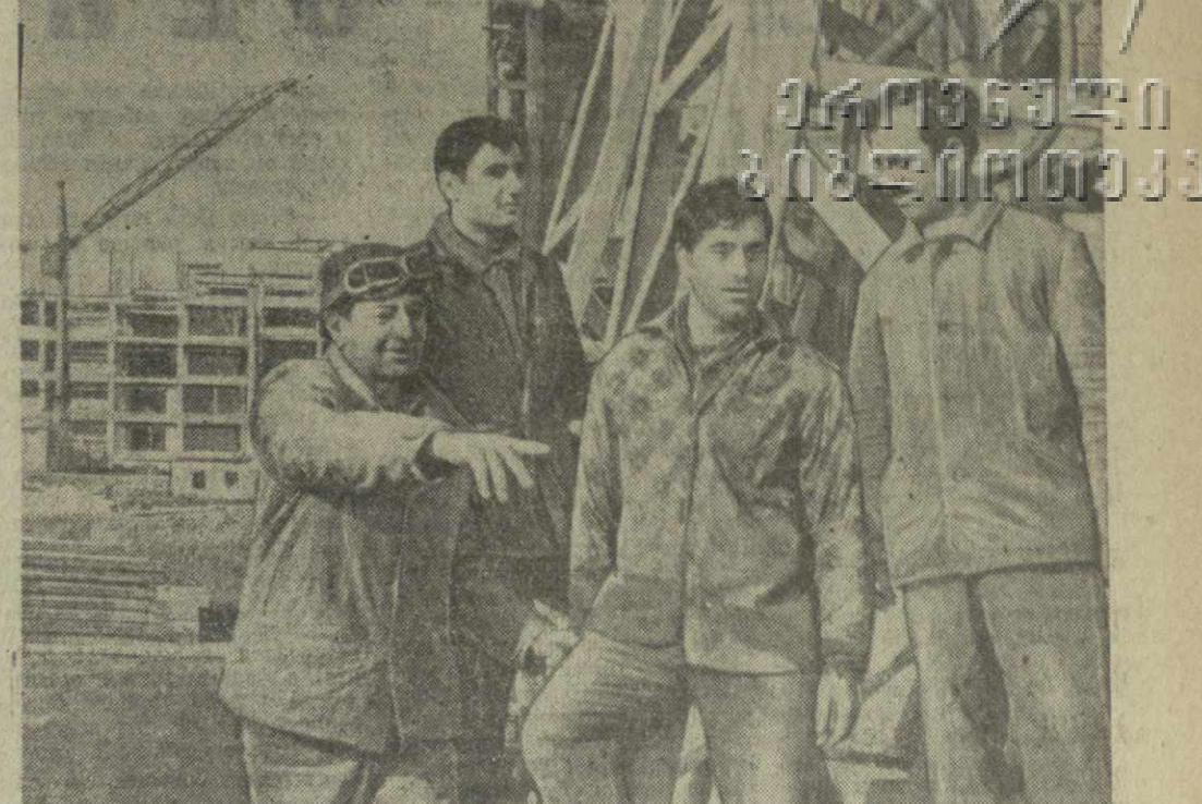
Строители комплекса лабораторий управления «Грузгеология» в Сабуртало, члены группы народного контроля: (слева направо) электростанционер В. Олейников, каменщик Д. Месхишвили, штукатур В. И. Папкини и каменщик В. Бунтури проверяют качество строительства на одном из участков.
