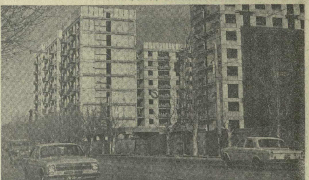
Тбилиси — огромная строительная площадка. Куда ни глянешь, всюду видны стрелы багнетных кранов. Это строители возводят административный корпус, жилые дома, гостиницы...
