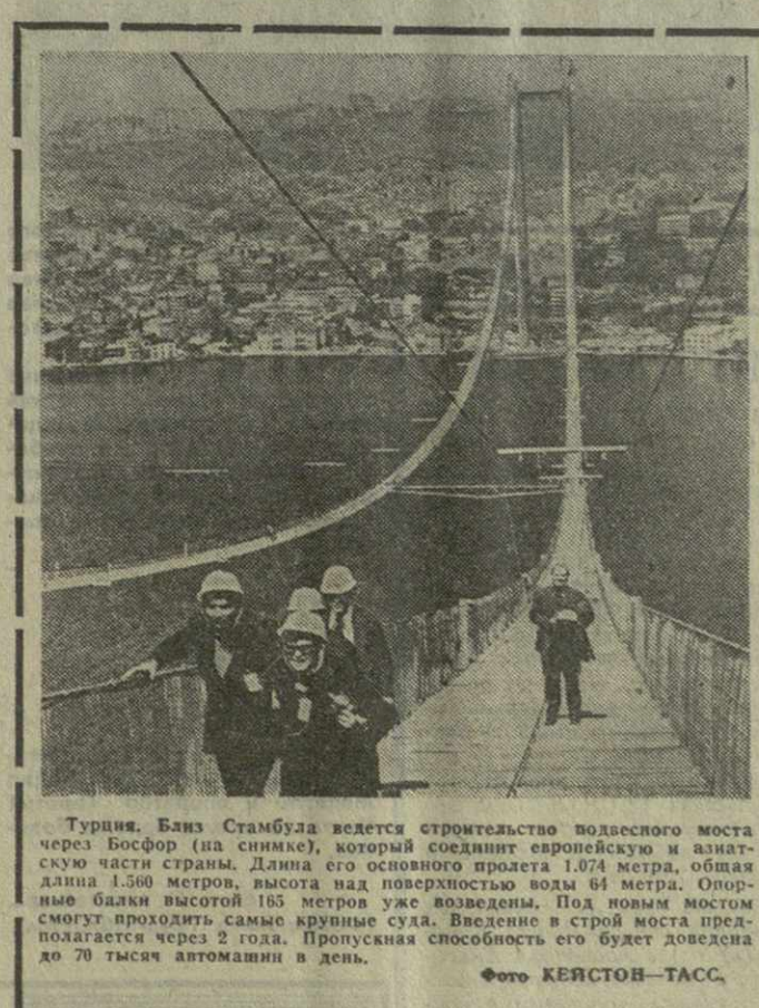
Турция. Визз Стамбула ведется строительство подвесного моста через Босфор (на снимке), который соединит европейскую и азиатскую части страны. Длина его основного пролета 1.874 метра, общая длина 1.590 метров, высота над поверхностью воды 61 метр. Оборудован башни высотой 185 метров уже возведены. Под новым мостом смогут проходить самые крупные суда. Введение в строй моста предполагается через 2 года. Прогнозная способность его будет доведена до 70 тысяч автомашин в день.
