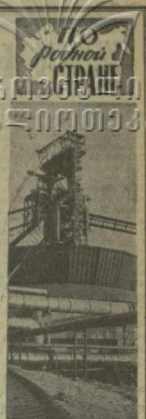
На Новолипецком металлургическом заводе введена в строй крупнейшая в стране плавильная печь. Объем ее — 3.200 кубометров. Ежегодно доменная печь будет выплавлять 2.200 тысяч тонн чугуна.
