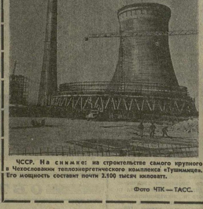
ЧССР. На снимке: на строительстве самого крупного в Чехословакии теплоэнергетического комплекса «Шумице». Его мощность составит почти 2.100 тысяч киловатт.
