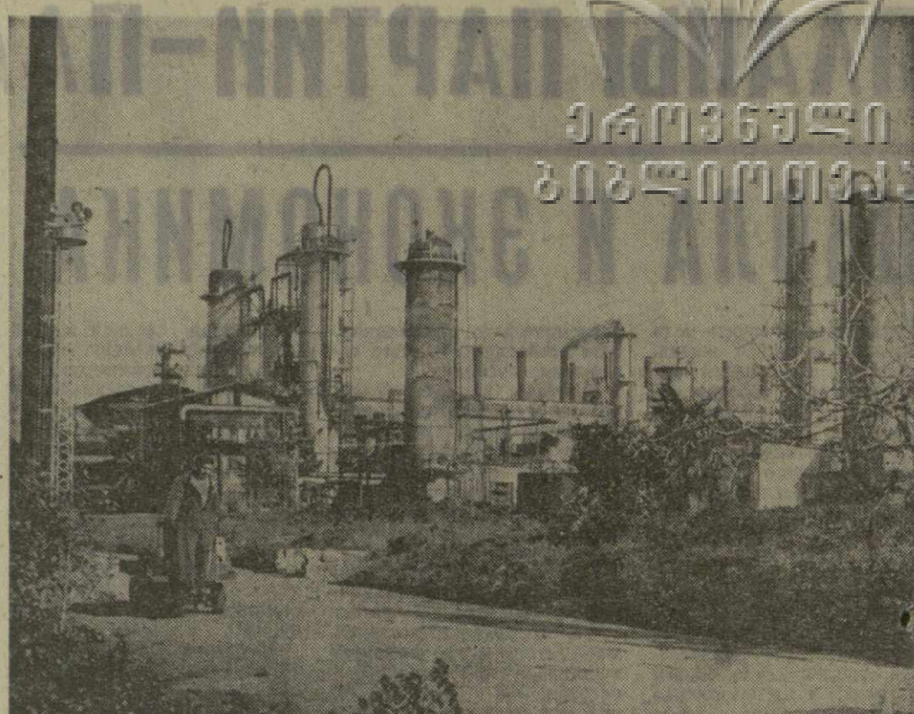
Батумский нефтеперерабатывающий завод — крупнейшее предприятие столицы Аджарии. Продукция этого предприятия отправляется в разные районы нашей страны, а также и во многие зарубежные государства. За годы своего существования завод преобразился, наполнился новой техникой, высокопроизводительным оборудованием.
