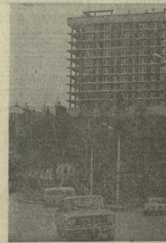
На снимке: вид на строящуюся в Телави 9-этажную гостиницу.
