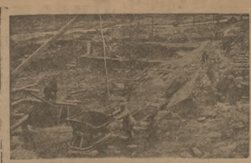
Канакиргас, Работы по строительству гидроэлектростанции.
