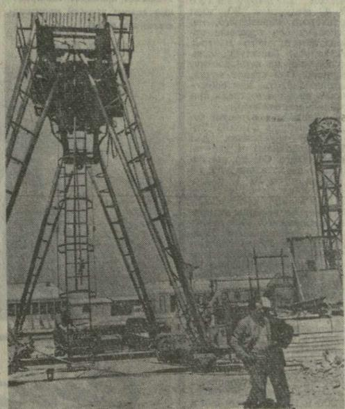
АНГЛИЙСКИЕ И ФРАНЦУЗСКИЕ СПЕЦИАЛИСТЫ ведут подготовительную работу по прокладке туннеля под Ла-Маншем, который свяжет Дувр и Британских островах с Кале в 51 километр. Общая протяженность сооружения — 51 километр, из них около 37 километров будут находиться под дном пролива. На поездку из Лондона в Париж потребуется два часа сорок минут. За один час по туннелю смогут проходить 3.600 автомашин.
