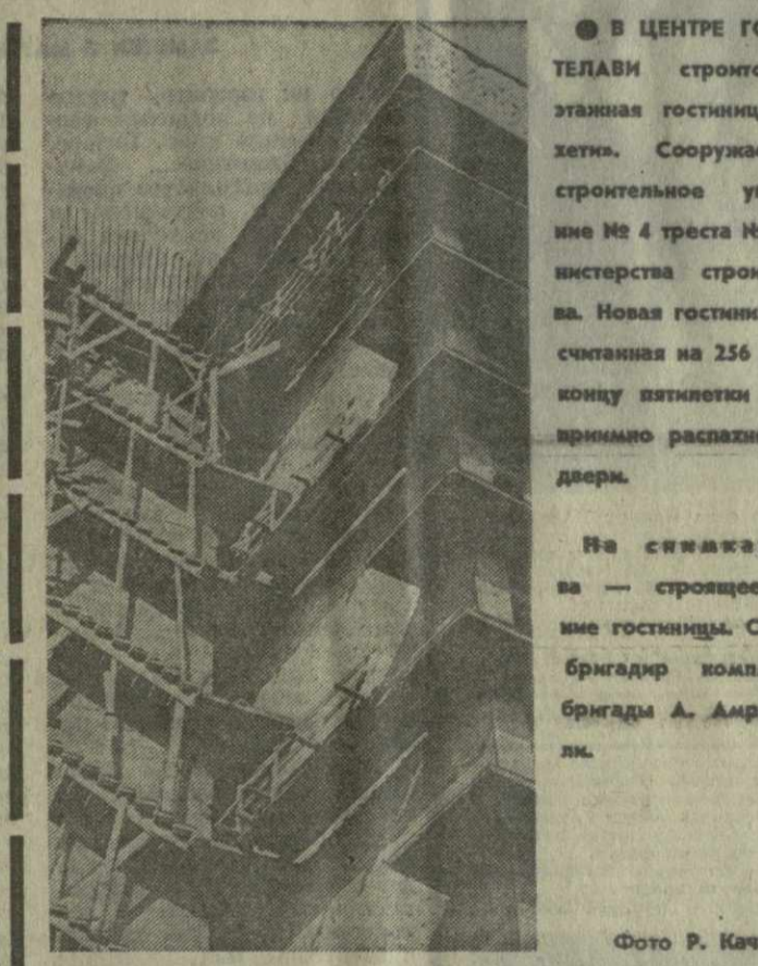
В ЦЕНТРЕ ГОРОДА ТЕЛАВИ строится 13-этажная гостиница «Колхид». Сооружает ее строительное управление № 4 треста № 2 Министерства строительства. Новая гостиница, рассчитанная на 256 мест, к концу пятилетия гостеприимно распахнет свои двери.
