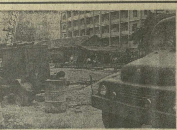
ХАНОЙ. На месте разрушенного американскими бомбами квартала Кхам-Тхен возводятся новые жилые дома.
