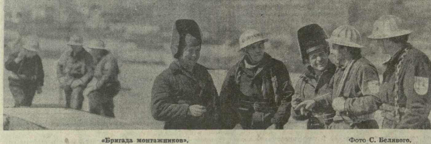
«Бригада монтажников», Фото С. Беляева.
