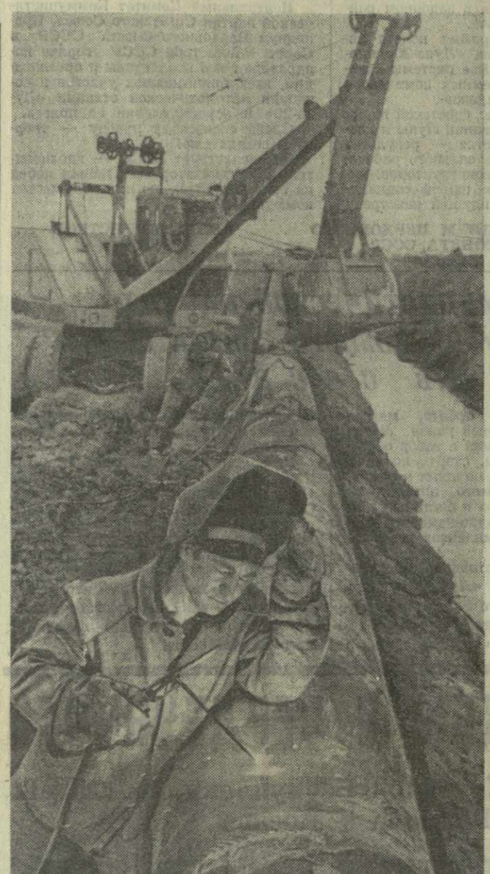
Полным ходом идет строительство многокилометровой линии водопровода Москва—Очамчыре, предназначенного для обеспечения нужд районного центра в питьевой воде. На стыковке труб водопроводной магистрали отключается сварщик Сухомского экспериментального завода газопараметры Юрий Седов (на снимке на переднем плане).
