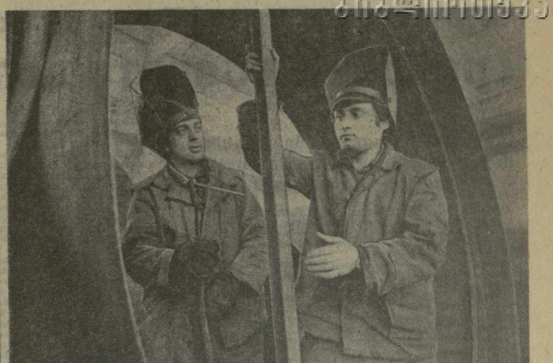
Передовые рабочие-электросварщики Тбилисского завода металлических конструкций Ю. Гагустов (слева) и Г. Заридзе досрочно выполнили план первого года девятилетки.
