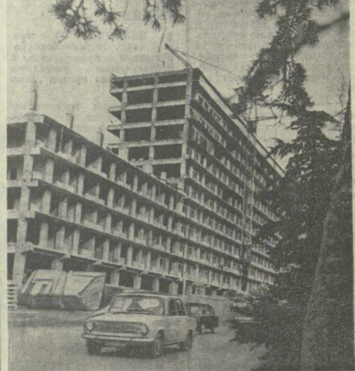
● ТБИЛИСИ СЕГОДНЯ. Строительство новых домов на улице Гурамишвили. Фото Е. Русака.
