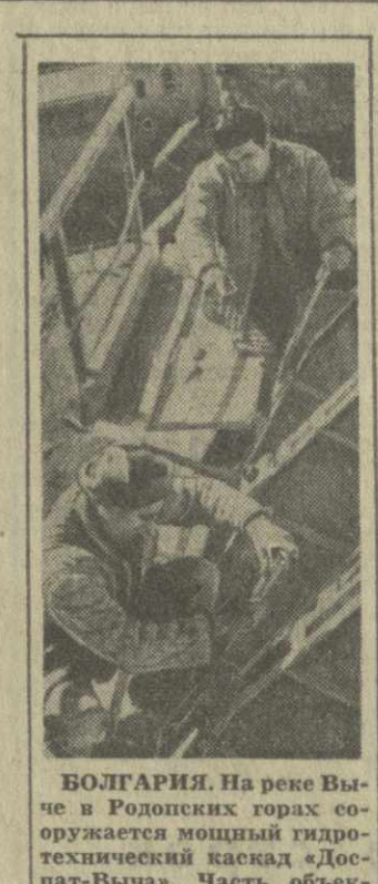
БОЛГАРИЯ. На реке Виче в Родопских горах сооружается мощный гидроэнергетический каскад «Доспат-Вича». Часть объектов уже завершена. Четверть турбоустановки общей мощностью 160 мегаватт дадут энергию Ловдину и другим промышленным центрам.
