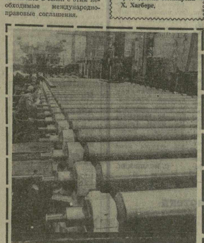
ЧССР. В цехах предприятия «Шкода» в Пльзене идет сборка оборудования для гигантского прокатного стана «Кварто-3600» (на снимке), который строится по заказу Советского Союза на Витковицком комбинате. «Кварто-3600», вес которого достигает десятков тысяч тонн, называют в Чехословакии «эскимосом столетия». Большинство узлов стана-гиганта уже доставлено в СССР. Фото ЧТК—ТАСС.
