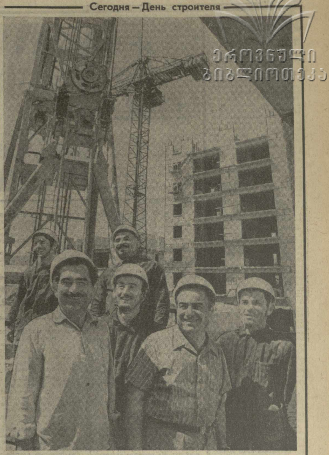
Коллектив 8-го строительного управления треста № 14 Главблестрой с хорошими показателями встретил День строителя.
