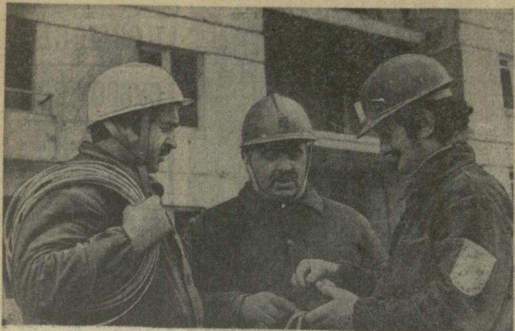
▲ БРИГАДА ЭЛЕКТРИКОВ Тбилисского монтажного управления № 1 треста «Грузэлектромонтаж» обслуживает объекты строительного треста № 14 объединения «Гавтблестрой». Коллектив коммунистического труда, возглавляемый В. Асабашивили, встав на трудовую вахту в честь 30-летия Победы над фашистской Германией, работает с значительным опережением графика. На снимке (слева направо): В. Асабашивили (бригадир), И. Гуджабидзе и Т. Магарашвили. Фото Г. Бумбашивили.
