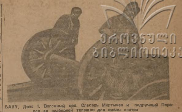
БАНУ. Доло. 1. Вагонный цех, Слесарь Мкртычев и подручный Переров за разборкой тележки для смены охватов
